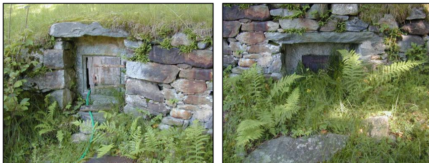
Costruzioni seminterrate in muratura ( cašòtt ) con portelli di legno contenenti le vasche per la decantazione dell'acqua degli acquedotti.
