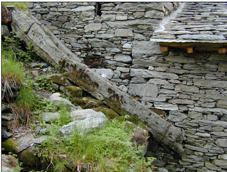
Canalizzazione dell'acqua per il complesso di servizi, oggi ecomuseo, di Piana Fontana (Mollia) comprendente fucina, mulino, forno, falegnameria e deposito di granaglie (prima del restauro).
