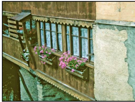
Balconata della casa che fu sede dell'Ospedale di San Carlo, della Mairie di Campertognetto e della Trattoria Grosso
