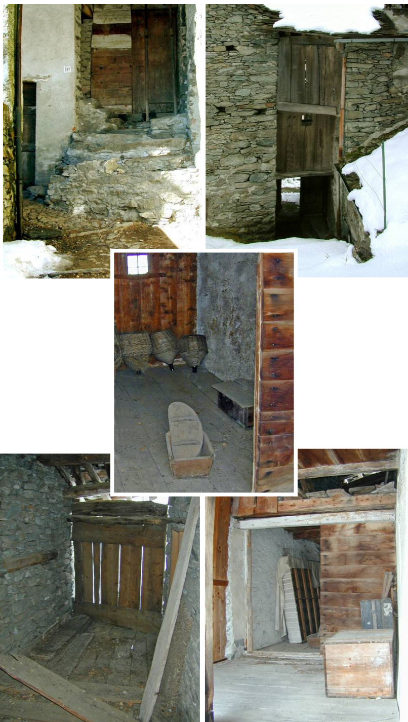
L'intercapedine tra le due case: situazione preesistente all'inizio dei lavori.
