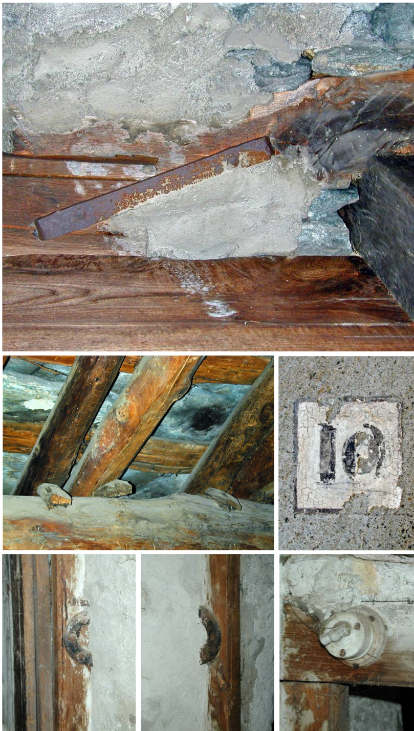
Particolari delle due case: situazione preesistente all'inizio dei lavori.
