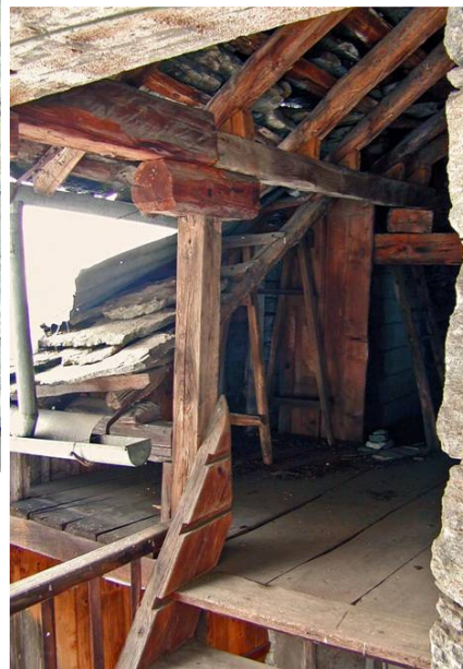
Le lobbies della Cà 'd la Šepina: situazione preesistente all'inizio dei lavori.
