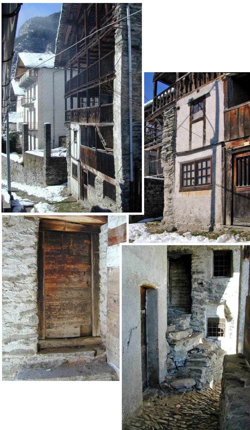
Gli ingressi della Cà dal Chél e della Cà 'd la Šepina prima dell'inizio dei lavori.
