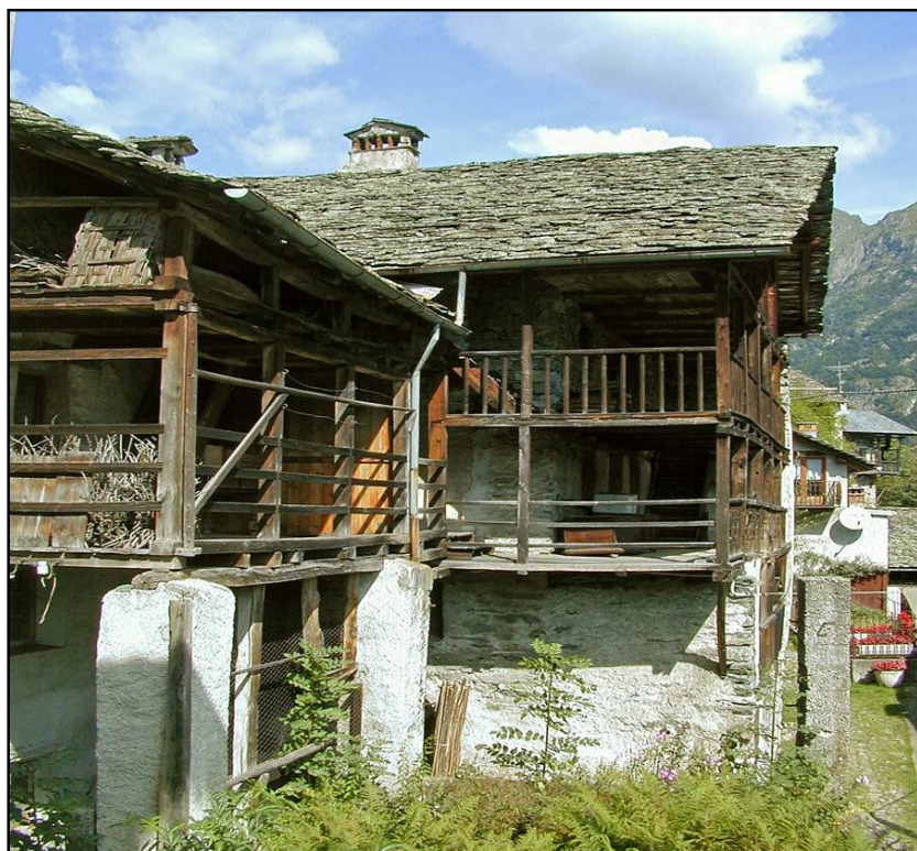
Prospetto da sud del complesso di Ca' dal Chél e Ca' 'd la Šepina prima dell'inizio dei lavori di ristrutturazione
