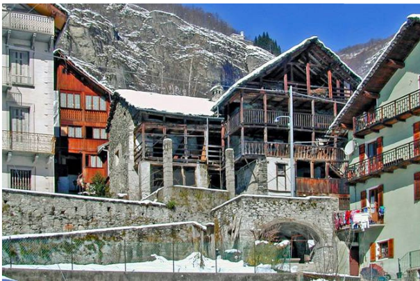
Lato orientale del complesso: situazione preesistente all'inizio dei lavori.
