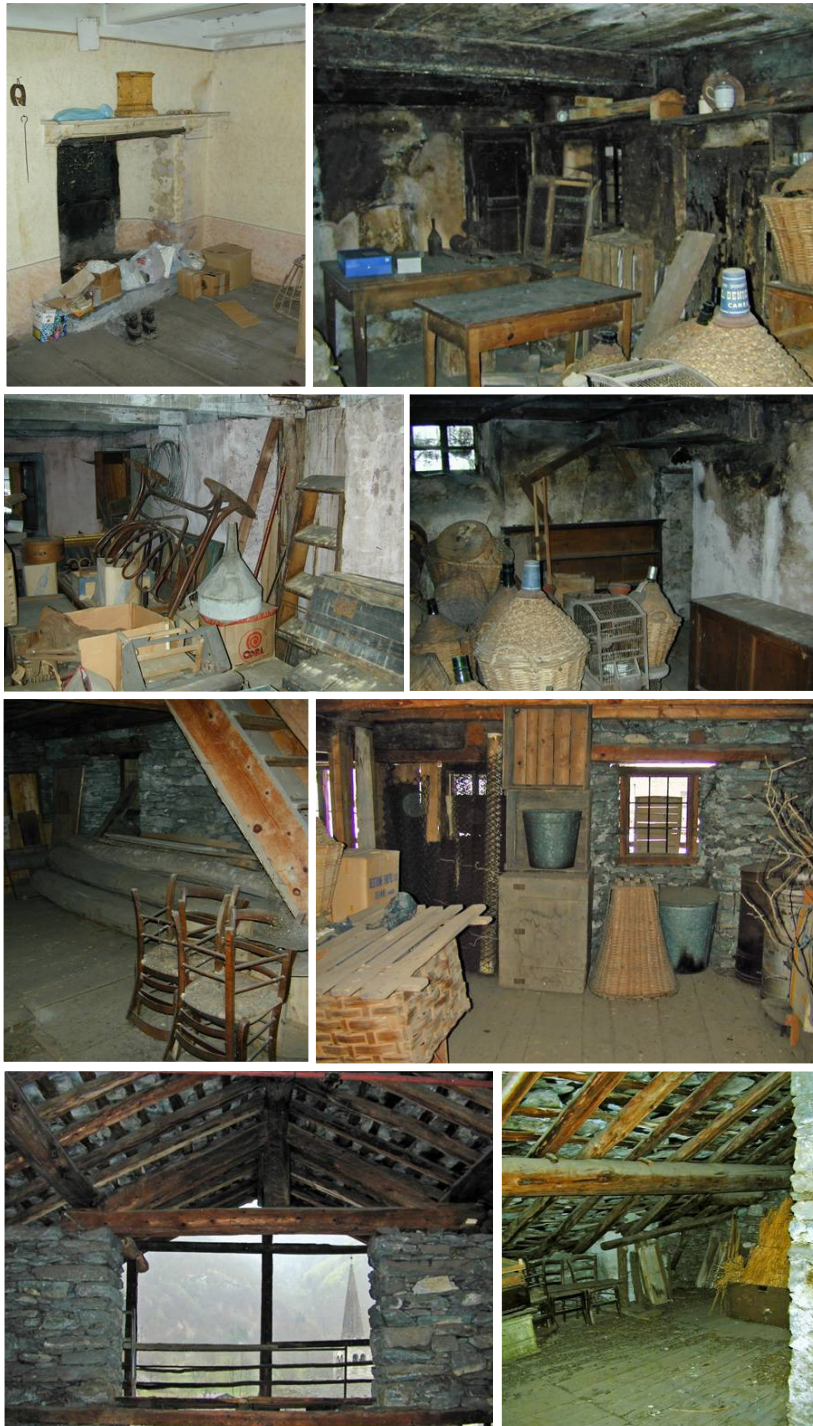
I locali della Cà dal Chét: situazione preesistente all'inizio dei lavori.
