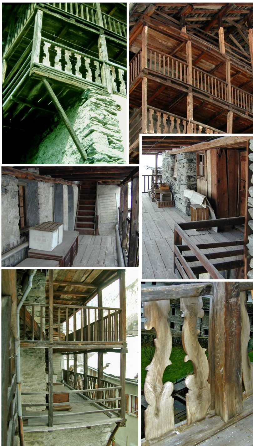
Le lobbie della Cà dal Chél: situazione preesistente all'inizio dei lavori.
