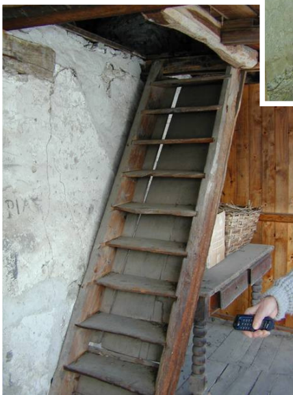
Le scale della Cà 'd la Šepina: situazione preesistente all'inizio dei lavori.
