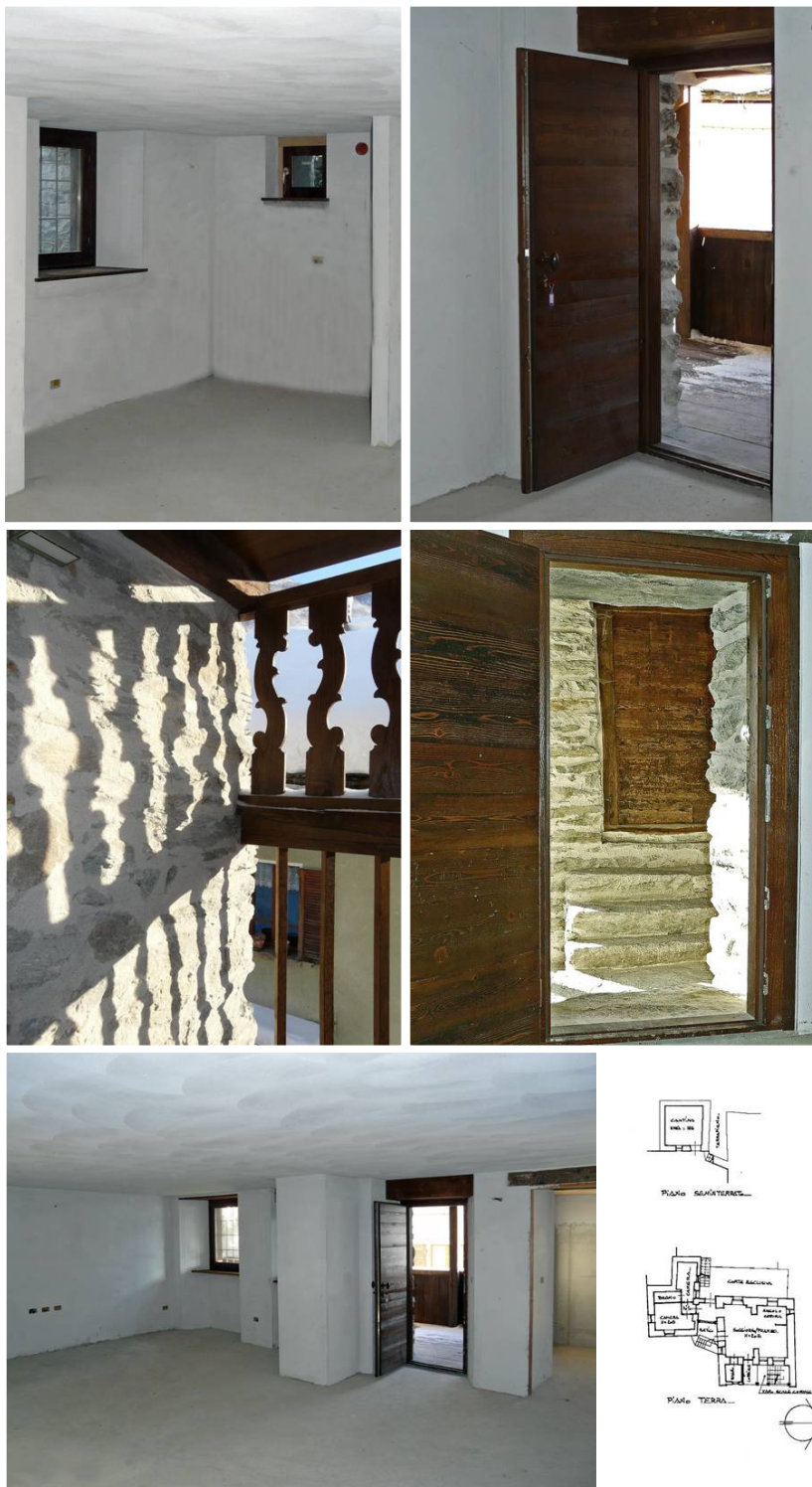
La Cà dal Ròc (alloggio al piano terreno) quale risulta al rustico dopo i lavori.
