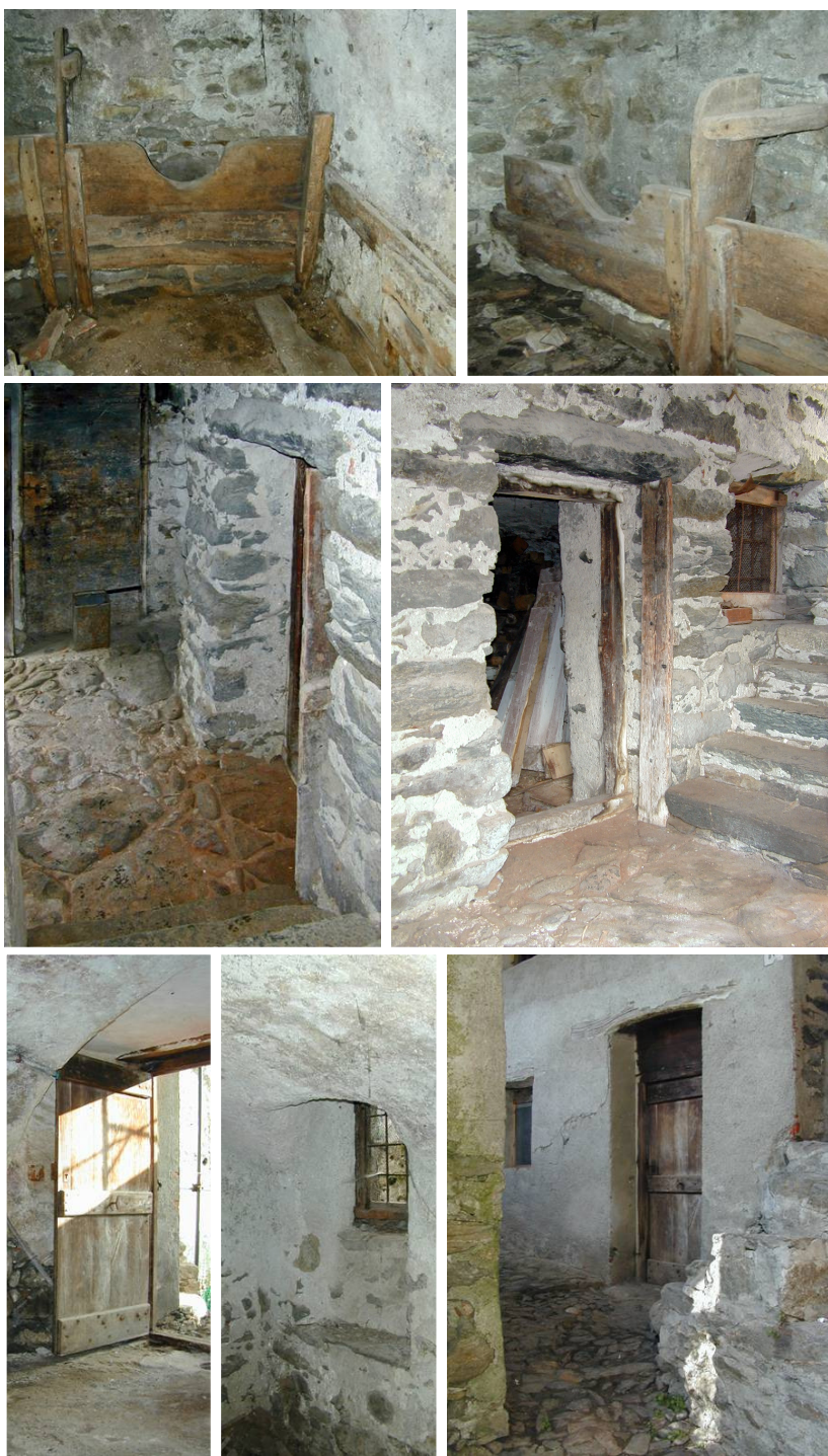
Le stalle delle due case: situazione preesistente all'inizio dei lavori.
