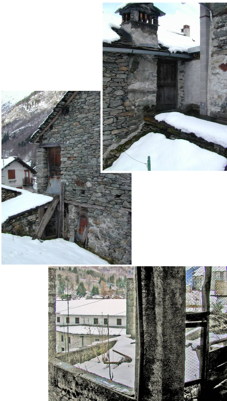
I terrazzini delle due case: situazione preesistente all'inizio dei lavori.
