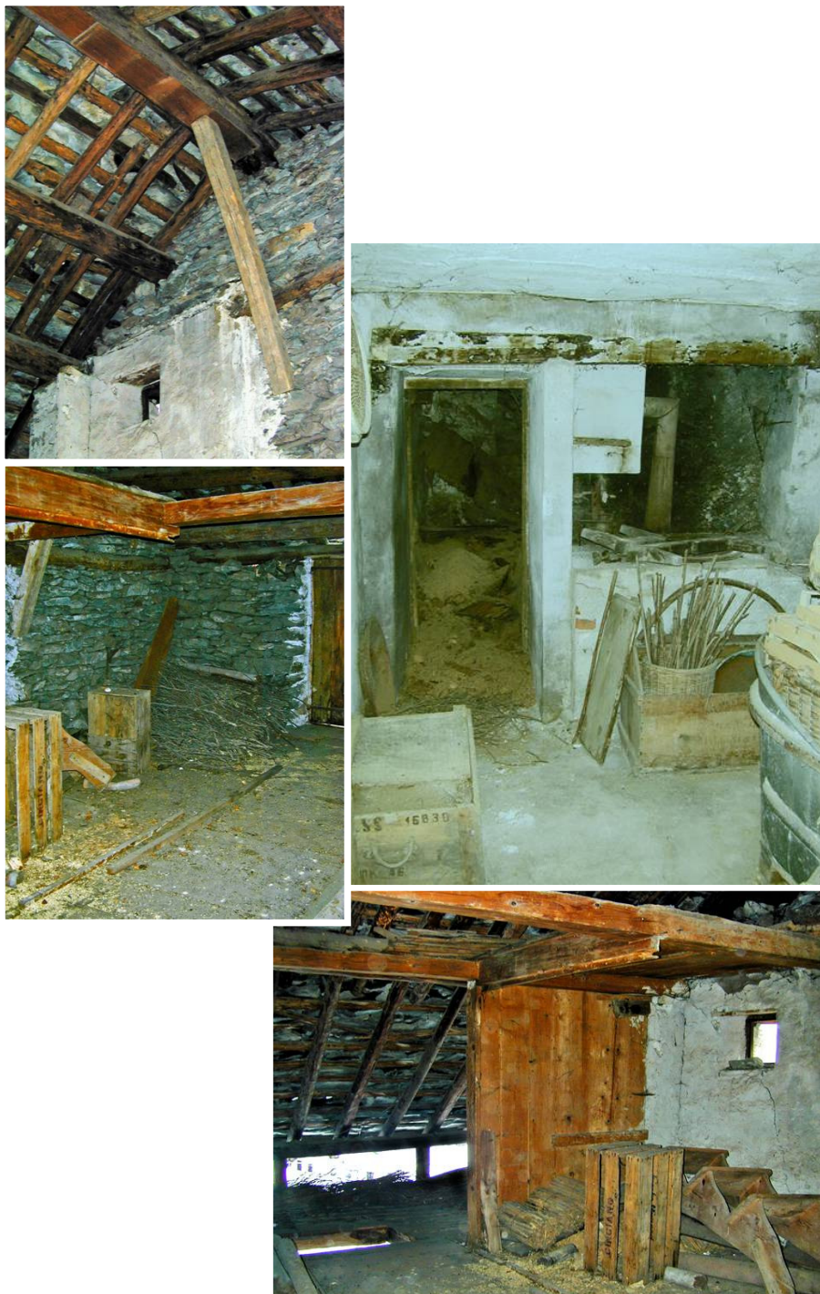
I locali della Cà 'd la Šepina: situazione preesistente all'inizio dei lavori.
