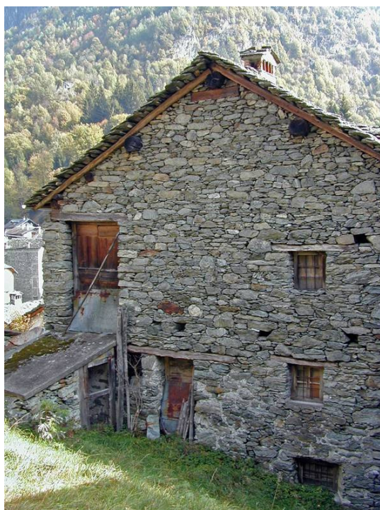
La riva retrostante le due case: situazione preesistente all'inizio dei lavori.
