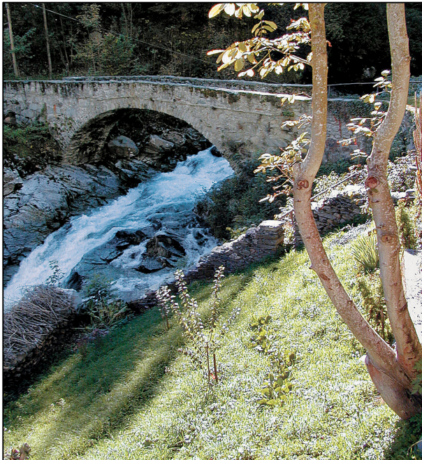
Il ponte sul torrente Artogna, visto dal sentiero che porta alla frazione Rusa.
